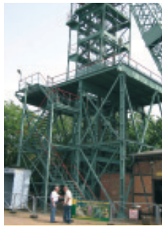
Ob sich hier auch etwas mit Fernwärme antreiben lässt? Foto: Klaus-Dieter Beßler
